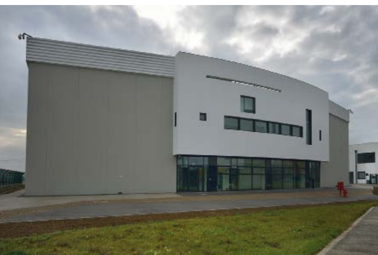
Reevo custodisce i dati dei clienti all'interno di data center certificati Tier IV, come il data center DATA4 di Milano (nella foto)
